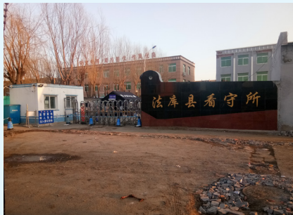
▲ 辽宁省沈阳市法库县看守所
