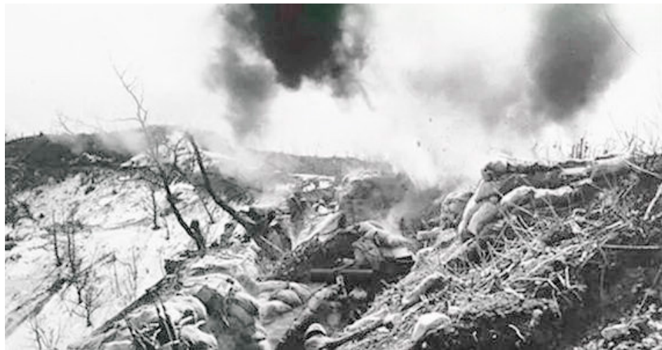
▼ 上甘岭表面阵地被炸为焦土。
